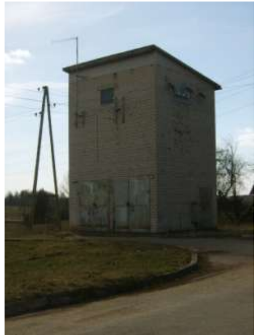
Transformators Grāveru ciemā, 2007
